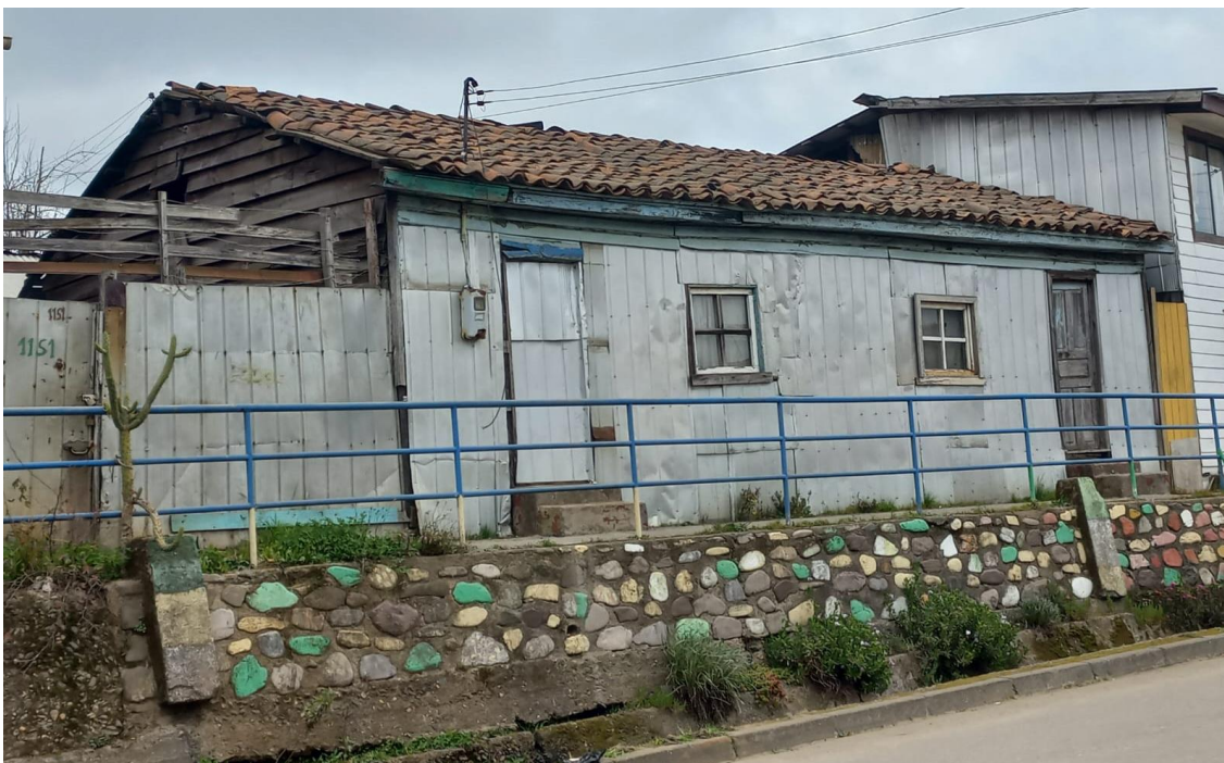
Figura 10. Terraplenes y muros de contención que conforman las aceras, adoptando la pendiente. Calle Sargento Aldea.
