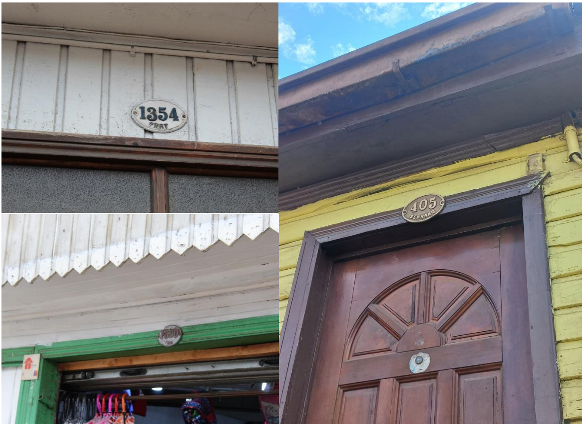
Figura 21. Placas de numeración de viviendas y edificios.
