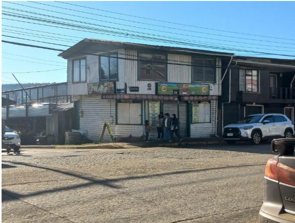
Acciones como la liberación de la esquina con ochavo y voladizo, son muestras de la reinterpretación de la Arquitectura Moderna a partir de la madera, en el sur de Chile. Fuente: Elaboración propia, 2024
