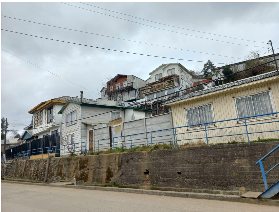
Figura 11. Terraplenes y muros de contención que conforman las aceras, adoptando la pendiente. Calle Sargento Aldea
