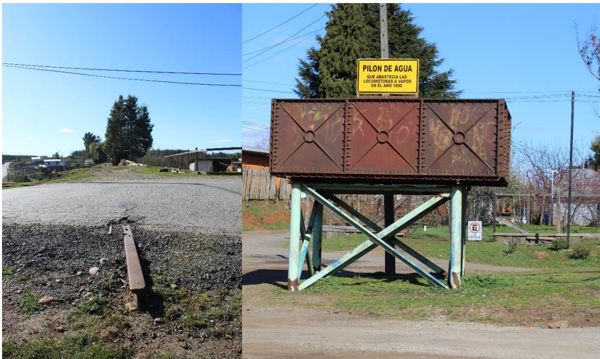
Figura 19. Remanente de vía férrea y pilón de agua para abastecimiento de locomotoras a vapor.
