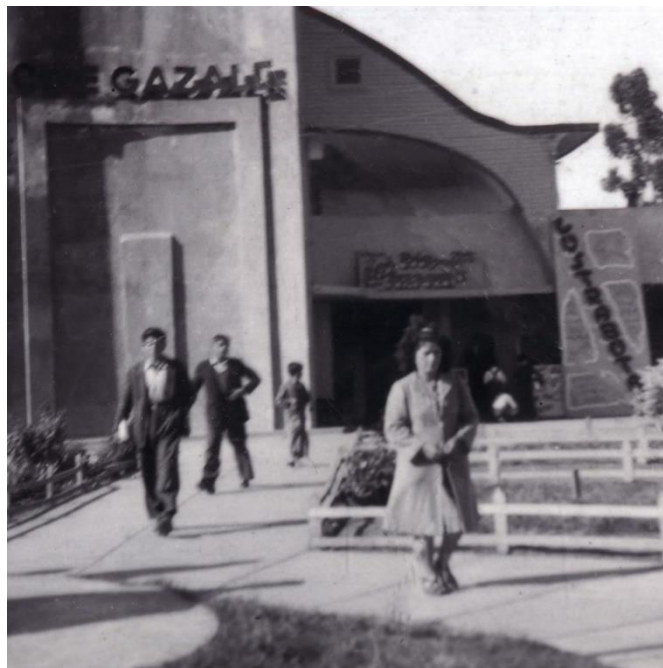
Figura 4. Cine Gazale, ca. 1944. Centro recreacional y social de la comuna, ubicado frente a la plaza, es demolido parcialmente décadas más tarde. Hoy es un restaurant, y se conserva, sin uso, parte del edificio antiguo.
