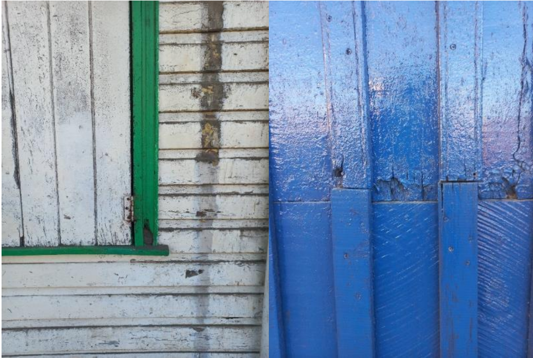
Revestimientos de madera tinglada o machihembrada. Ejemplos de los entablados que concurren en Calle Prat.
