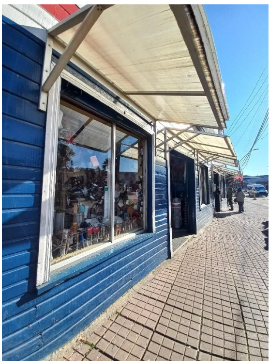
Intervención en fachada para proteger vitrinas de luz solar y lluvia (filtración en vanos). Genera una espacialdiad intermedia coherente con condiciones climáticas.
