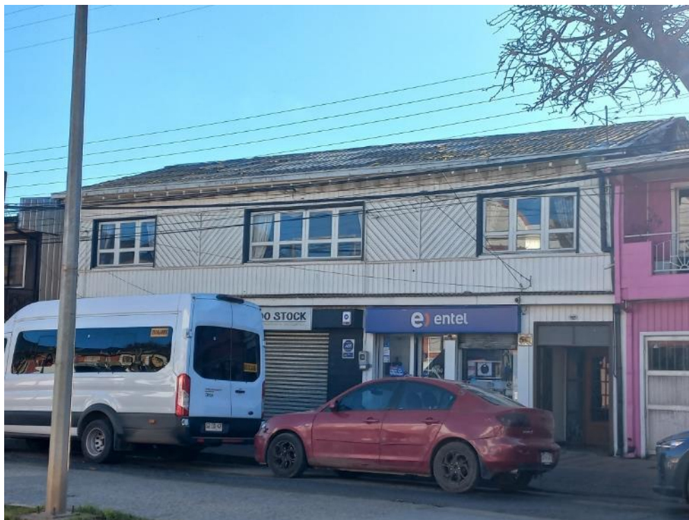
Los ornamentos en las edificaciones se realizan a partir de las posibilidades que da el mismo revestimiento, alternando el sentido de las tablas y generando composiciones en la fachada. Fuente: Elaboración propia, 2024
